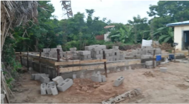
Magazzino in costruzione
